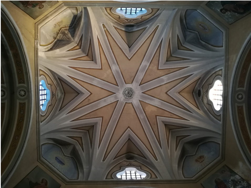
Fig. 5. Chiesa Madre di Carovigno (BR), dedicata a Santa Maria Assunta in cielo (XIV-XIX secolo): particolare dell'intradosso del settecentesco sistema voltato stellare composito ad ombrello (foto 2021, Ilaria Pecoraro).
