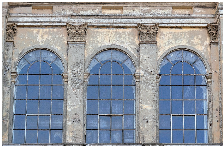
Figg. 22-23. Villa Pallavicino delle Peschiere, facciata nord, loggia del piano nobile, il classico motivo del sistema voltato inscritto nel sistema architravato; Villa Grimaldi “la Fortezza”, loggia del piano nobile, che riprende lo stesso motivo a doppio ordine, con gli archi a tutto sesto impostati ad una quota più bassa su semi-pilastrini con andamento arretrato rispetto al filo delle paraste: immagini con saturazione e desaturazione selettiva, maschera di contrasto e filtro artistico “contorni poster”.
