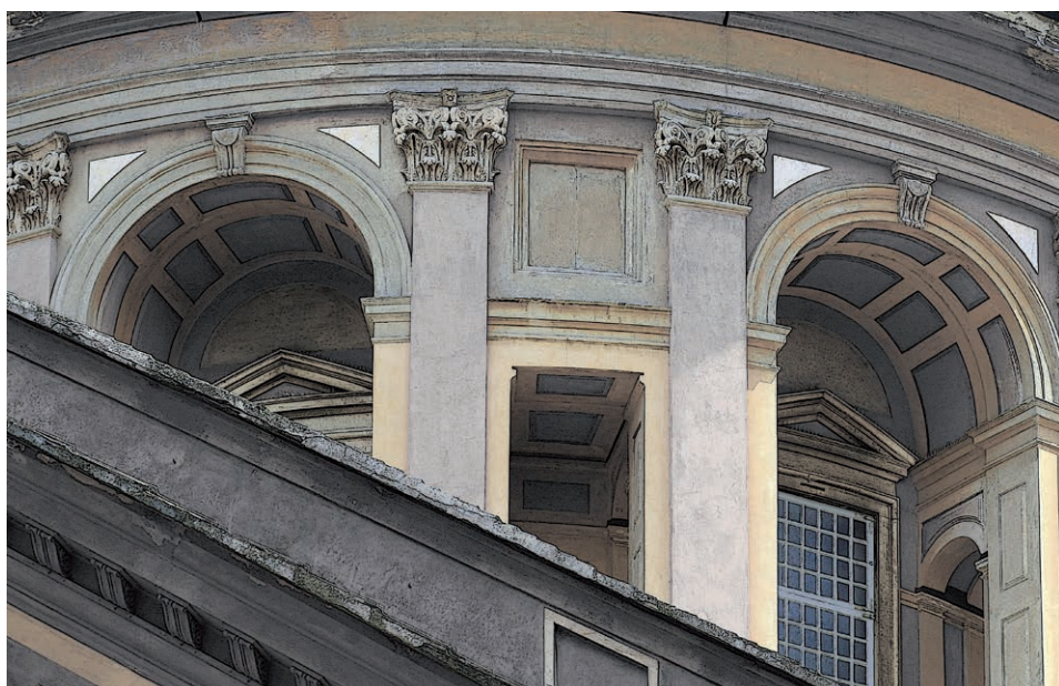
Figg. 1-2. Basilica di Carignano, particolare del tamburo, con il suo ritmico susseguirsi di paraste corinzie e archi a tutto sesto: immagini a colori e immagini con desaturazione, maschera di contrasto e filtro artistico "contorno poster".
